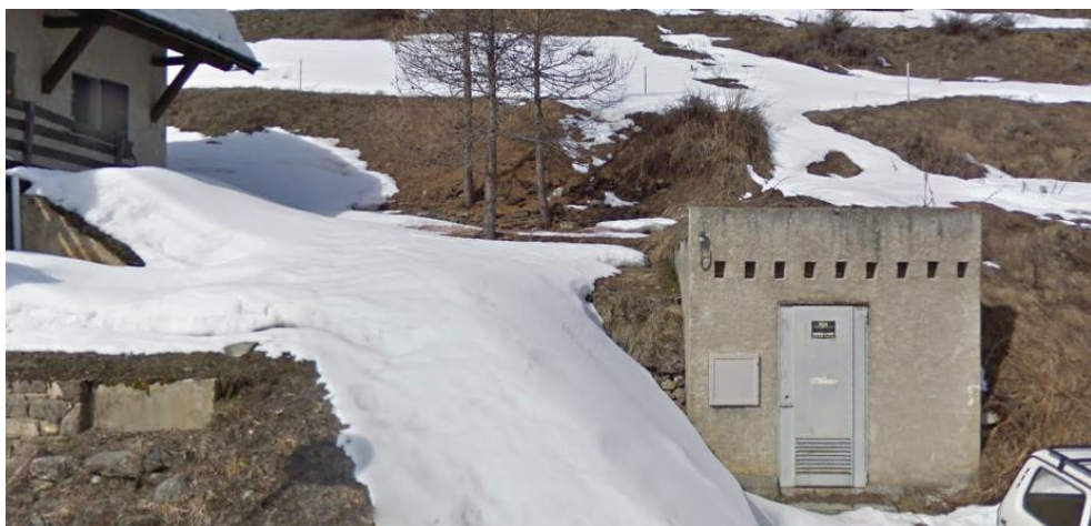
Poste de transformation sur la parcelle D0639 – Source : Google Street View
