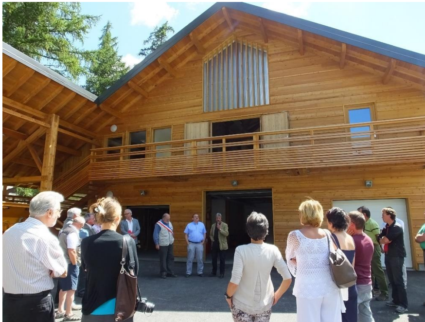
Ateliers municipaux de la commune - Source : 100constructionsbois.com
