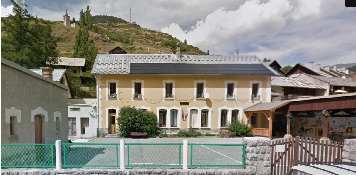
Ecole d'Abriès – Source : Google street view
