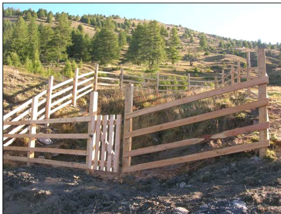
Photo 15 : PPI regard source de Varenc (Source : HYDRETTUES le 29 sept. 2011)
