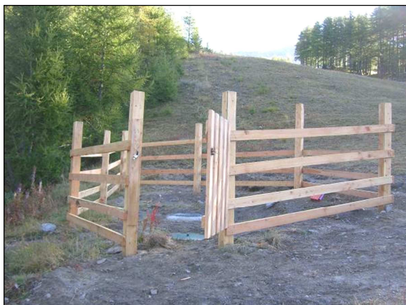
Photo 17 : Clôture autour du réservoir du Varenc (Source : HYDRETTUES le 29 sept. 2011)
