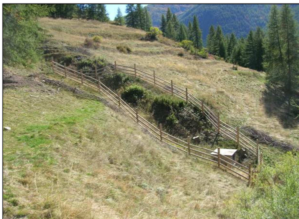
Photo 1 : Aspect extérieur du captage – Mounal 1 (Source : HYDRETTUES le 2 sept. 2012)
