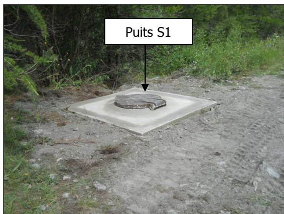
Photo 19 : Environnement extérieur du puits S1 (Source : HYDRETTUES le 13 juillet 2013)
