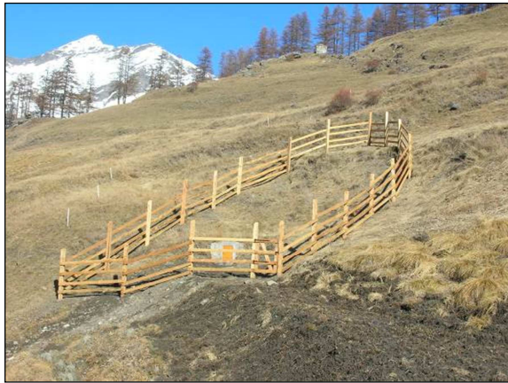
Photo 13 : Aspect extérieur du captage – Sagnes (Source : HYDRETTUES le 25 nov. 2011)
