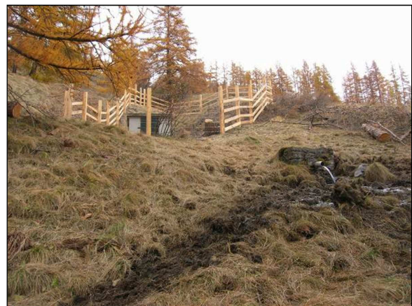
Photo 2 : Aspect extérieur du captage avec trop-plein – Mounal 1 (Source : HYDRETTUES le 3 nov. 2011)
